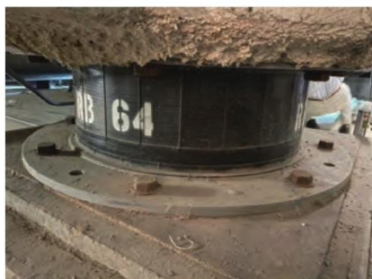
写真8 高減衰ゴム系積層ゴム支承
