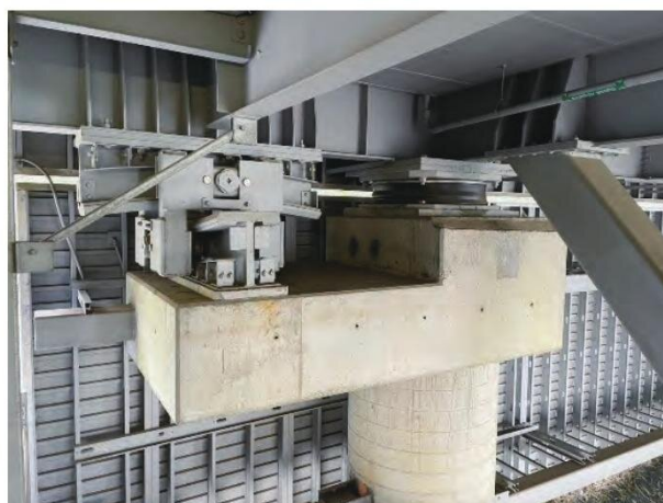
写真7 引抜き抵抗部材
