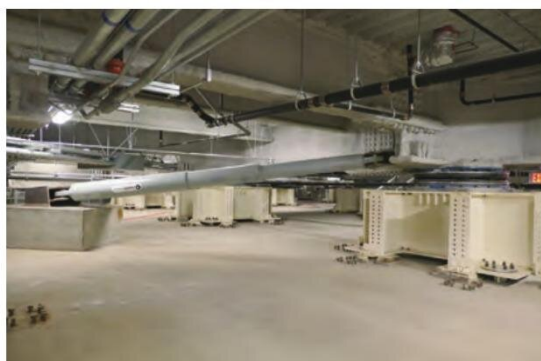
写真18 流体粘性ダンパー
