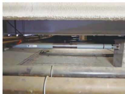
写真10 流体粘性ダンパー
