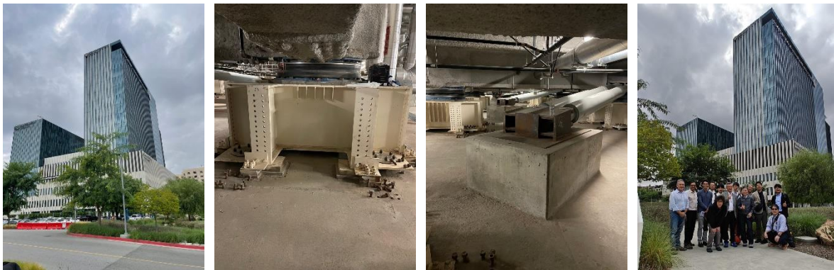
Loma Linda 大学病院の外観、免震層、集合写真
