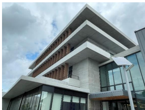
写真1 建物外観（その1）
