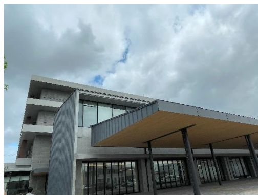
写真2 建物外観（その2）
